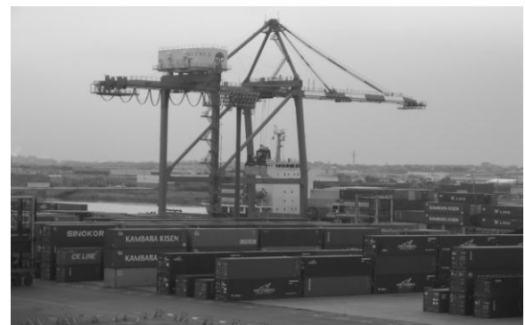
4号岸壁のスーパーガントリークレーン
