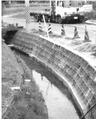
工事中＝7月3日撮影
